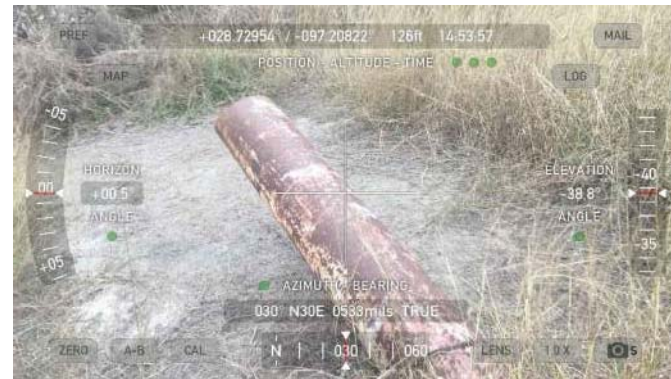
2276 - Exterior Pipe Outlet
