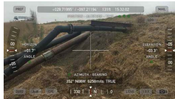
2349 - Exterior / Pipe Corridor
