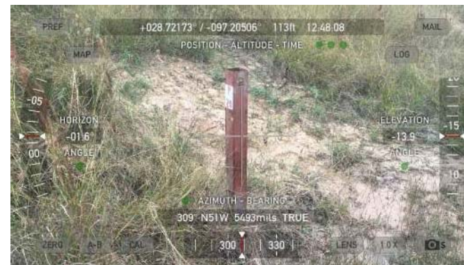
2133 - Exterior - Piezo 20 (Wet Area)
